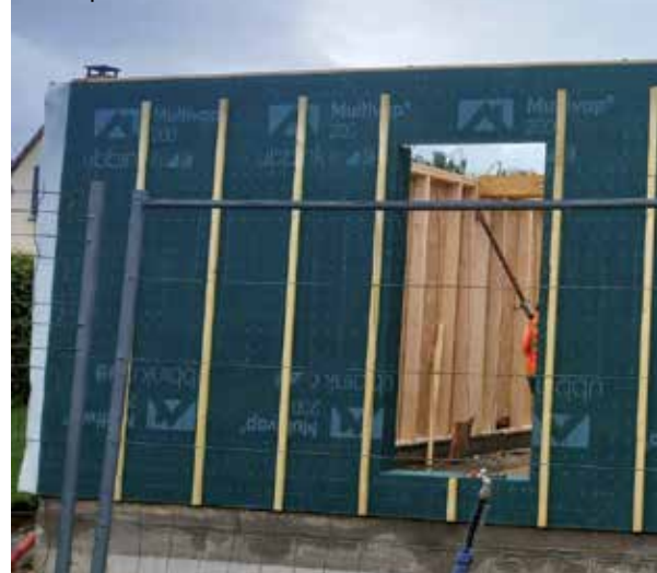
La pose des murs
